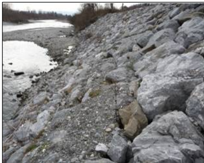
Photo : rive droite en aval du seuil
