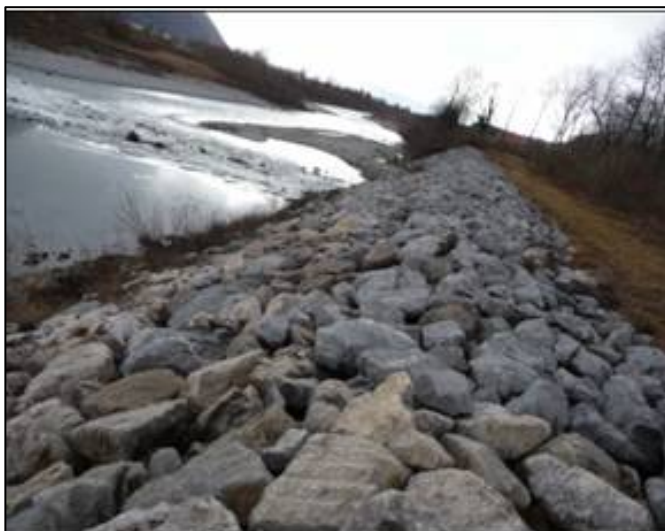
Photo : rive droite en amont du seuil
